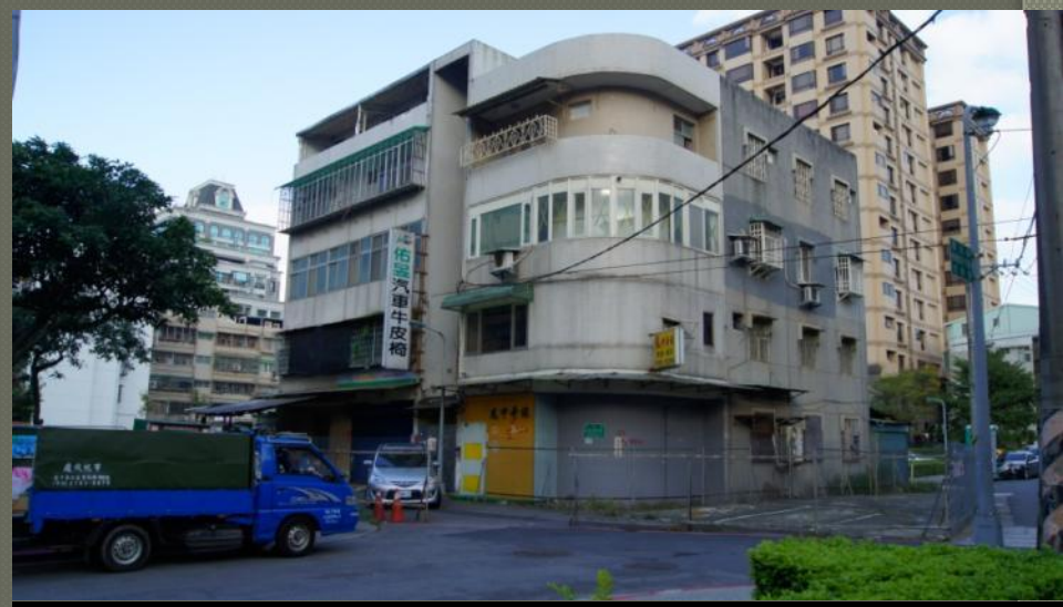
B. 212地號合法建物(4層樓鋼筋混凝土造)
